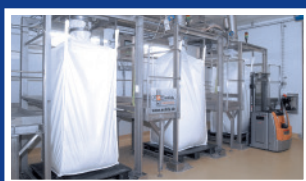
» DESCARGA DE SACOS Y BIGBAGS
